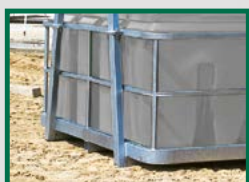
› Metalowe zabezpieczenie zbiornika
